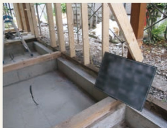
無筋の基礎補強工事
