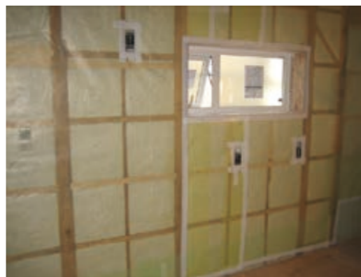
開口部入替、断熱材補強、防湿・気密シート貼り
