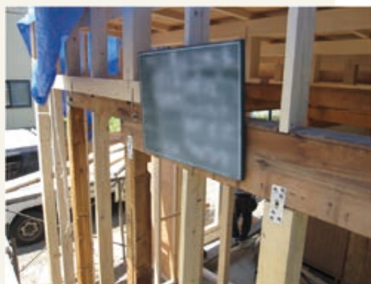
金物補強 梁補強
